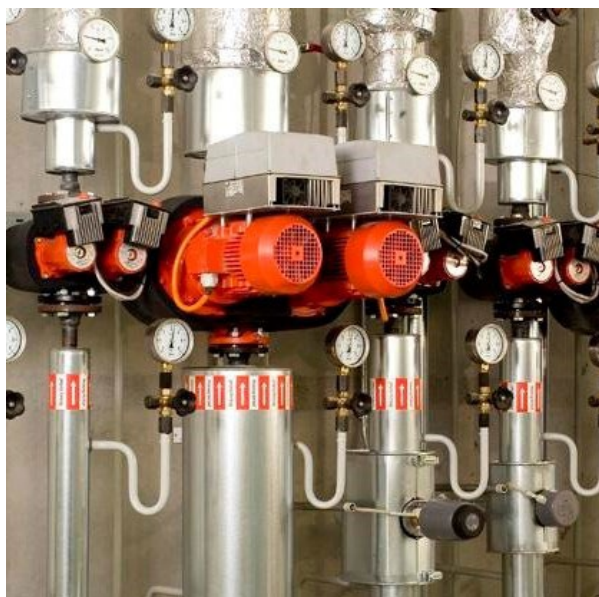
Umwälzpumpen unterschiedlicher Baugrößen im Einsatz.
